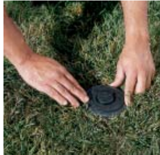
2. Enrosque todo el cuerpo/emergente ATR en la base existente.
